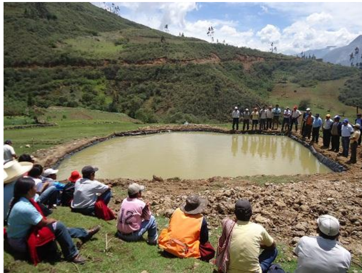
Foto 8: Reservorio para el riego tecnificado
